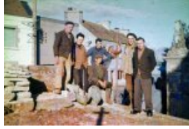
remplacement du coq sur le clocher de l'église
